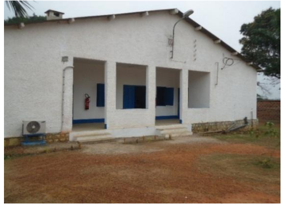
Le local qui fait office de bureau PAM Kindamba, Vindza et Kimba
