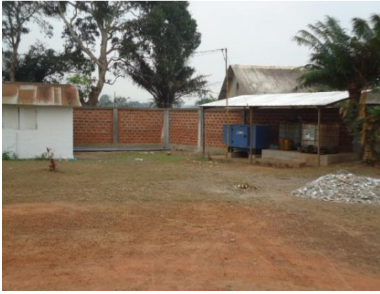
Murs de clôture, de sécurité et générateur de 33 KVA PAM Kindamba
