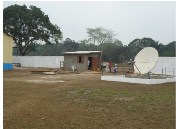
Travaux de fixation de portail encours site PAM kindamba
