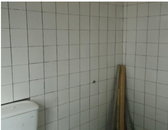
Une vue des toilettes intérieures du bureau PAM kindamba
